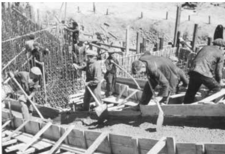
Les ouvriers français réquisitionnés travaillent sur le chantier du Mur de l'Atlantique.
